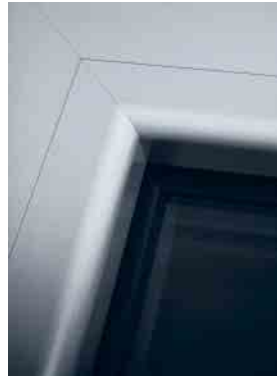
Glasleiste auf Gehrung Mitred glazing bead
